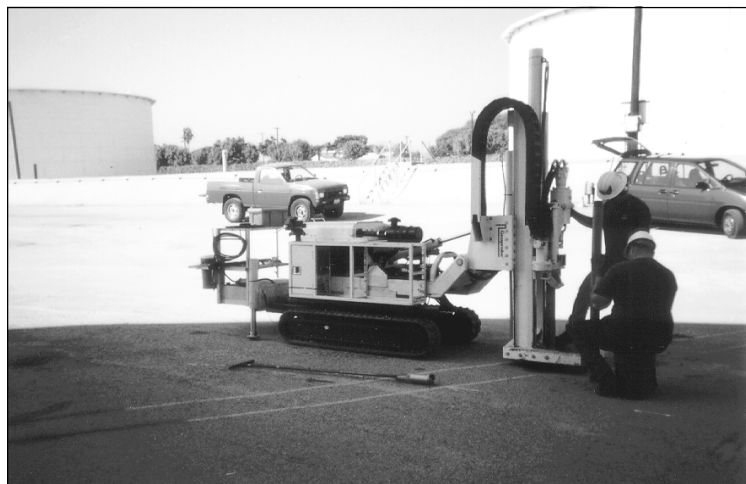
Inyección de aire. La instalación de pozos de inyección de aire (se ven aquí en el 2000) ha mejorado la limpieza.
